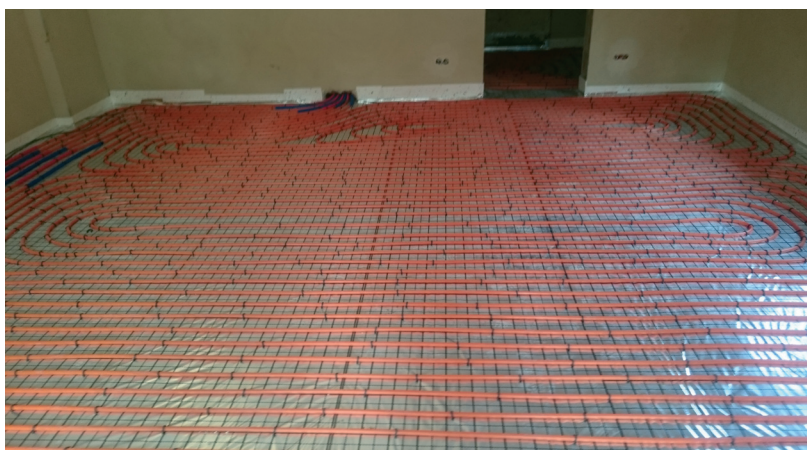
4. Ogrzewanie podłogowe z rur PEX DN17 z powłoką antydyfuzyjną układanych w odległości co 10 cm, a przy dużych przeszkleniach – gęściej
